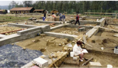
Erste Grundmauern des Badneubaus
